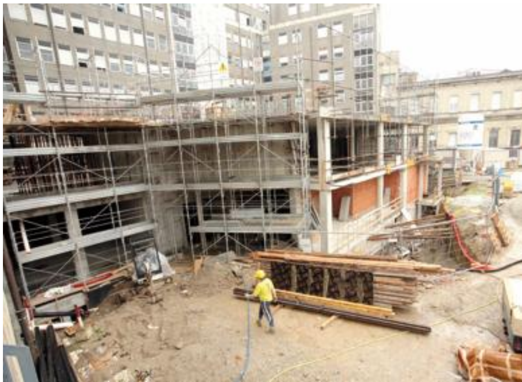
Il maxi cantiere dell'ospedale Maggiore di Lodi, avviato per la costruzione del nuovo Pronto soccorso, opera molto attesa
